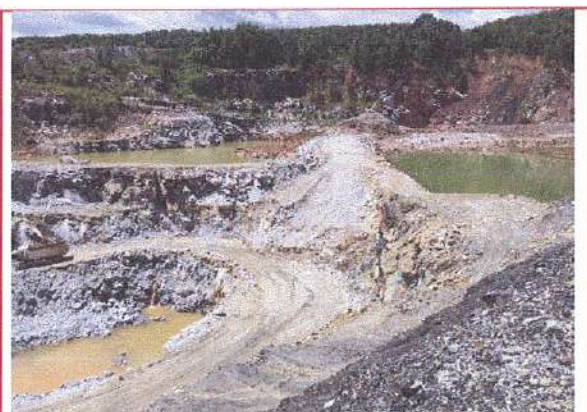
รูปที่ 4 ปล่อยคัดตะกอนดินรองรับน้ำจากคูระบายน้ำและ น้ำจากขุมเหมือง
